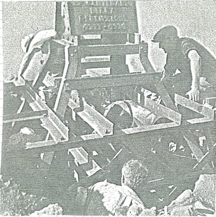
I lavori per le fondamenta.
